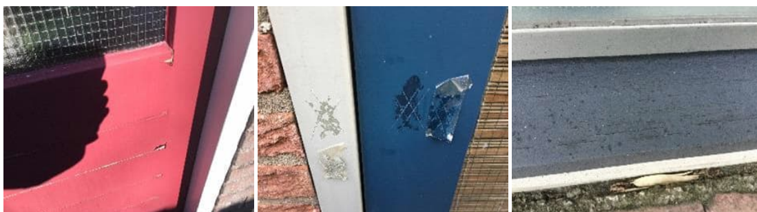
Foto 1: Afbladdering en sterke verpoederen. Deur met voltoonkleur sterk verkleurd
